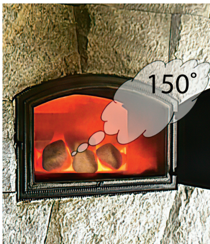
Рис. 6. Накал-печь по-серому, т.е. заряд калился в огне (по-чёрному), но сама печь с трубой, т.е. по-белому. Закрытая каменка
