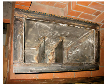
Рис.2. Бункер для каменки по-белому – камни калим через стенку корыта (слева), сетка для камней по-чёрному , помещаемая в огонь печи (справа).
