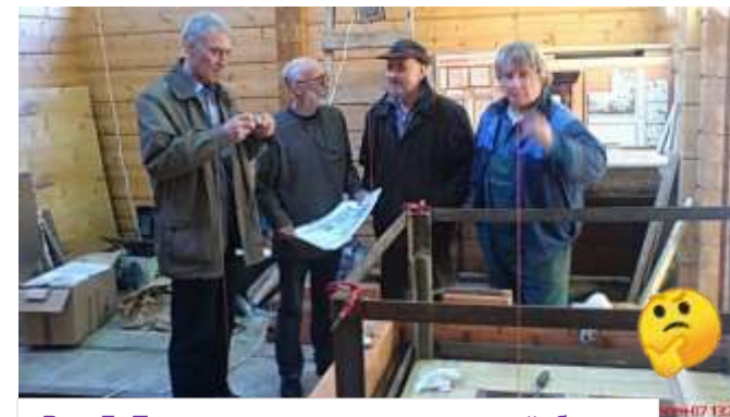
Рис. 7. Печники строят печь в элитной бане.
