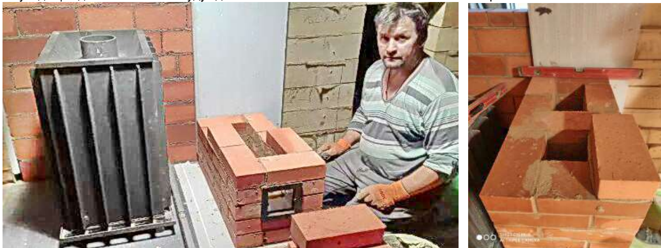
Рис. 5 Щиток из кирпича добавляет дымообороты.
