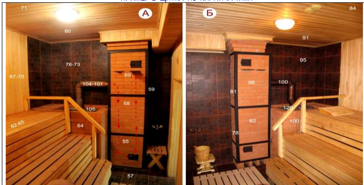
Рис. 7 Распределение T^\circ по печи и щитку, в бане в Щёлково.
