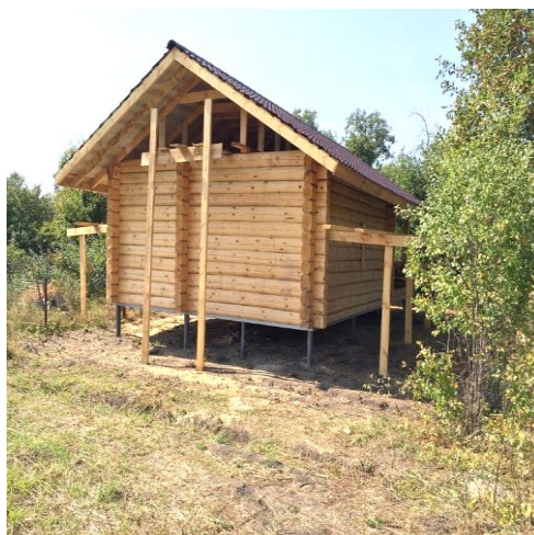
Рис.9-6. Строим баню на сваях. Большой козырёк кровли.
