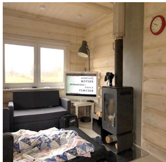
9-4. Металлич. печь и ТермоФан на ней. для ускорения конвектив. прогрева
