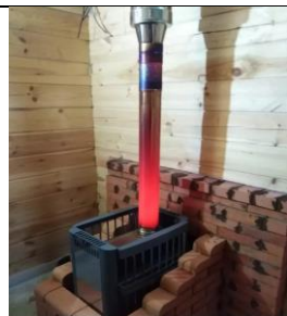
Рис. 7-3 Мощный огонь раскаляет трубу и происходит выброс огня над крышей
