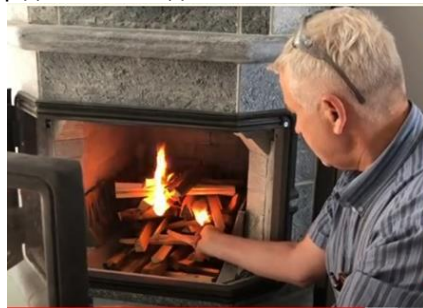
Рис. 7-1,а Поджиг и горение сверху увеличивает КПД сгорания и отбора тепла. Пономарёв А.В. разжигает сверху. Для 2-й закладки сдвигает угли к задней стенке. .
